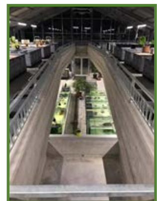
Vue générale des deux étages du bâtiment principal
