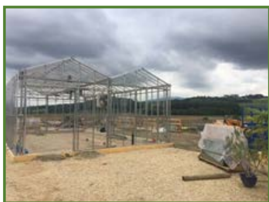
Construction de la serre froide pour les espèces sub-tropicales
