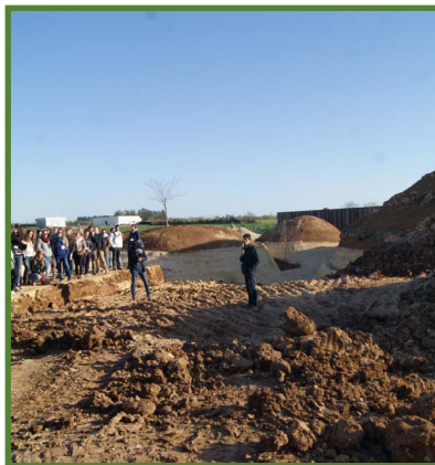
Visite du chantier de la nouvelle zone du Bioparc
